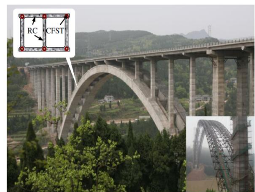
(d) Zhaohua Jialing River Bridge
